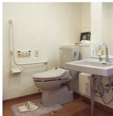
各居室には、車いす対応の洗面ユニットや 暖房・脱臭機能付トイレを標準装備しています。
